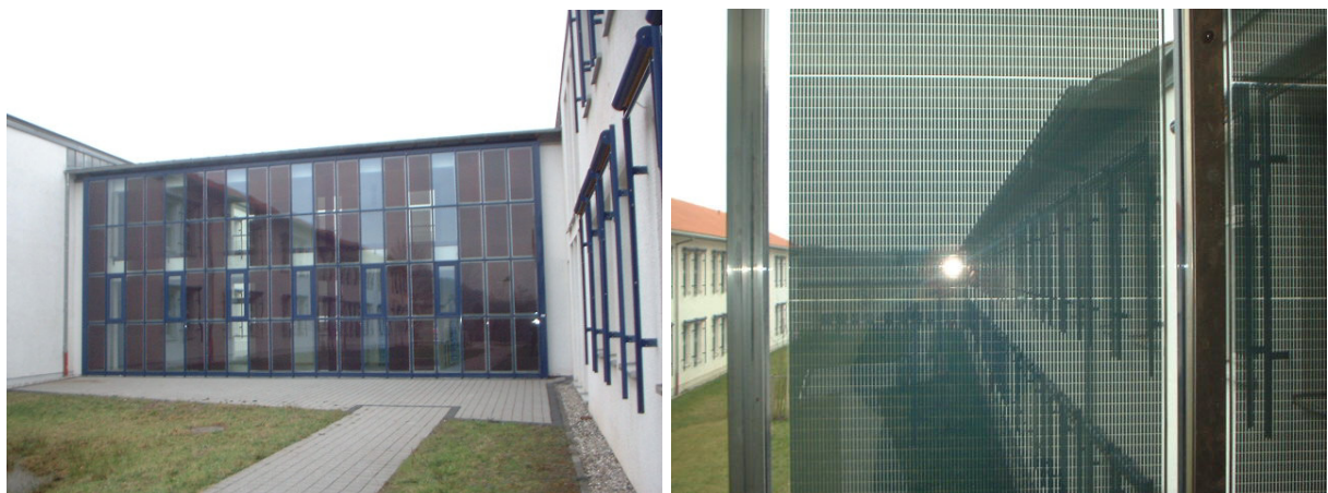
Bild 2: Eine der 15 Solarzellen-Fassaden des Umwelt-Campus Birkenfeld
